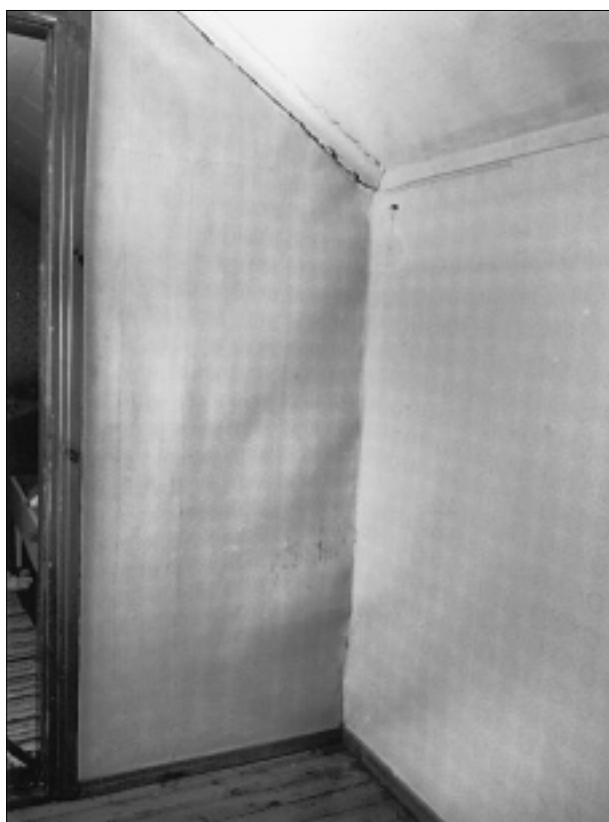
Löystynyt tai epätasainen pinkopahvi voidaan kiristää uudelleen sileäksi.
