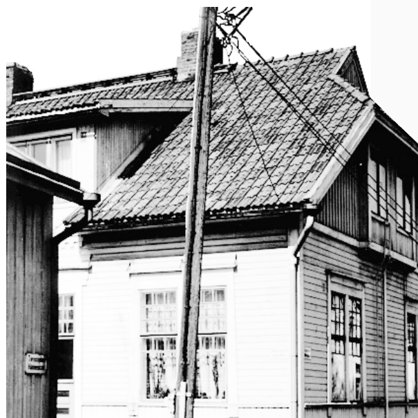
2 Valmistustavan kehittyminen teki tiilikatosta tiiviin ja täsmällisen. Valssitiiliä vuosisadan alkukymmenillä rakennetussa talossa Pietarsaaressa. Museovirasto 1982.
