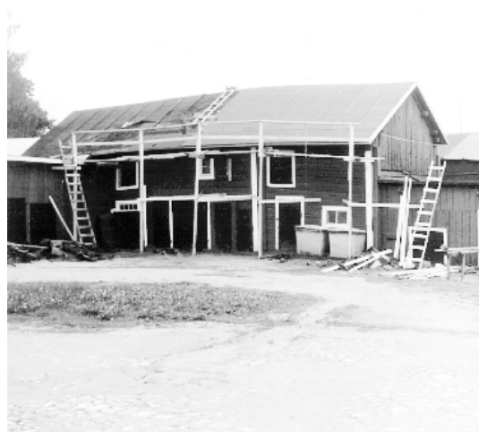
Kattotyö vaatii telineet, jos räystäitä joudutaan korjaamaan tai koko kate uusimaan.
